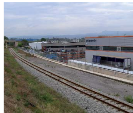
El tren tramvia hauria de tenir baixadors al seu pas pels polígons industrials
